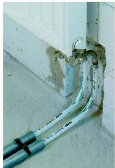
Fig. 9: Ejemplo de instalación: conexión de un radiador de válvula incorporada con accesorio de conexión de radiadores en ángulo RAUBASIC press desde el pared
