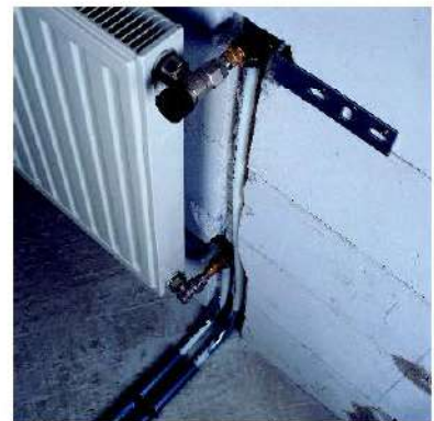
Fig. 6: Ejemplo de instalación: conexión de un radiador estándar con codo de pared RAUBASIC press 16 Rp ½" y soporte Z 42
