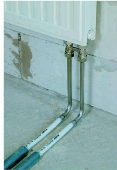
Fig. 7: Ejemplo de instalación: conexión de un radiador de válvula con el accesorio de conexión de radiadores en ángulo RAUBASIC press desde el piso
