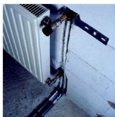
Fig. 6: Ejemplo de instalación: conexión de un radiador estándar con codo de pared RAUBASIC press 16 Rp ½" y soporte Z 42
