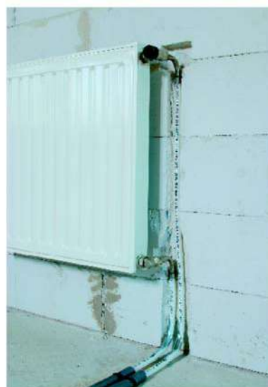
Fig. 4: Ejemplo de instalación: conexión de un radiador estándar con conexión en ángulo RAUBASIC press
