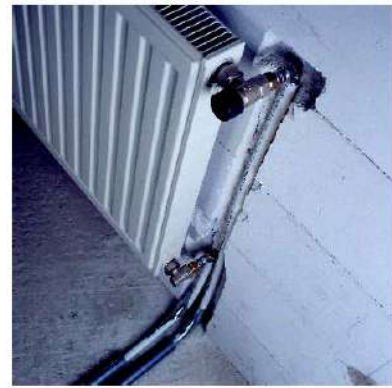
Fig. 5: Ejemplo de instalación: conexión de un radiador estándar con acoplamiento RAUBASIC press con rosca exterior
