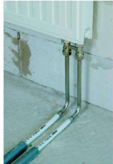
Fig. 7: Ejemplo de instalación: conexión de un radiador de válvula con el accesorio de conexión de radiadores en ángulo RAUBASIC press desde el piso
