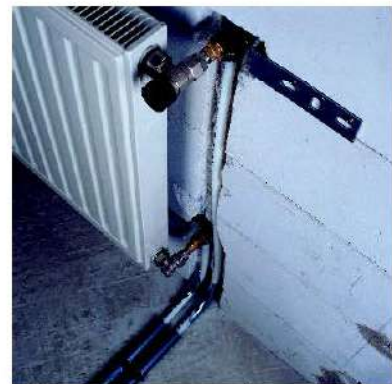
Fig. 6: Ejemplo de instalación: conexión de un radiador estándar con codo de pared RAUBASIC press 16 Rp 1/2" y soporte Z 42
